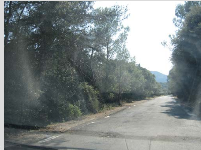
Trazado y estado del firme
